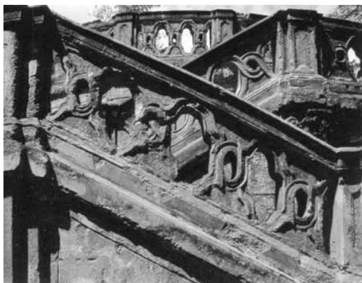
A mellvédszer a felújítás előtt
